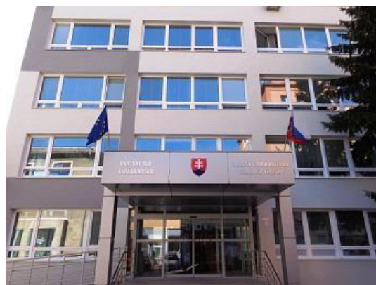
Obr. 2 – vchod do budovy okresného súdu
