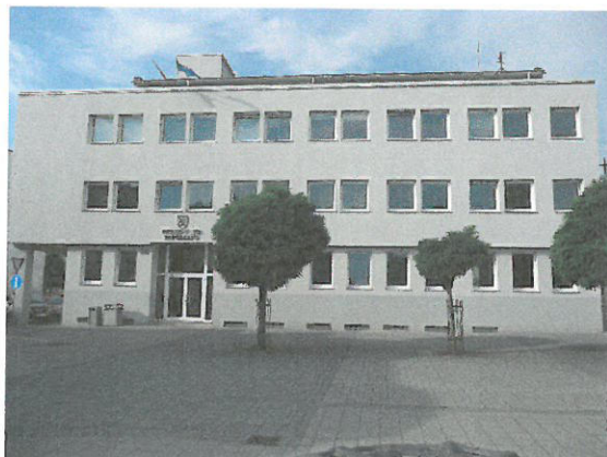
Obr. 1 – budova Okresného súdu Topoľčany
