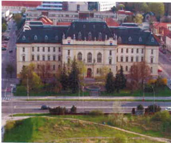
Obr. 1 – budova Okresného súdu Nitra
