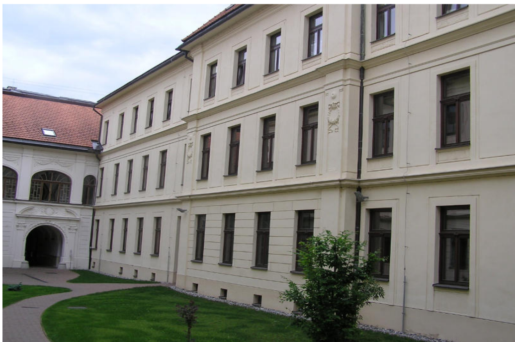
obr. 2 časť budovy bod B
