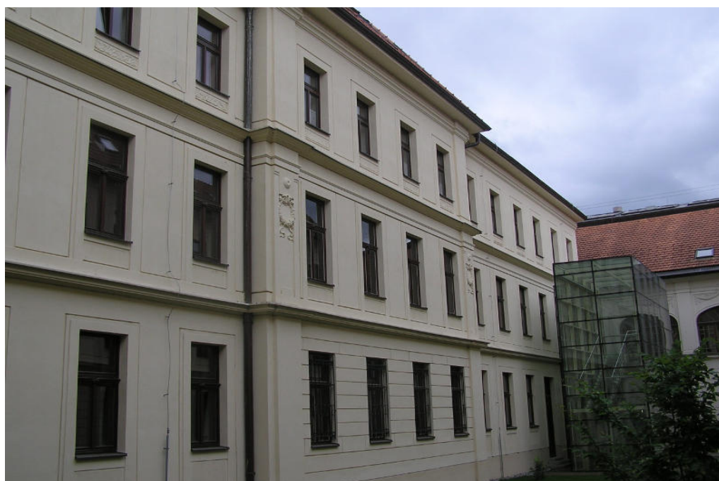
obr. 3 časť budovy C
