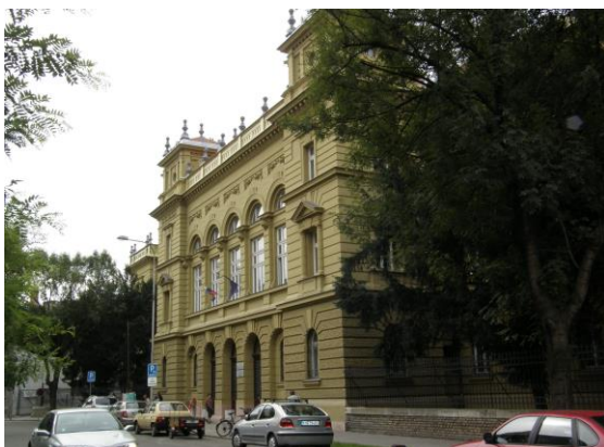
Obr. 1 – budova Okresného súdu Komárno
