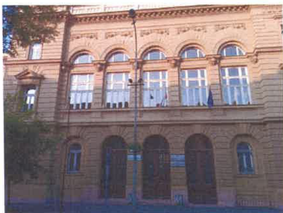
Obr. 1 – budova Okresného súdu Komárno
