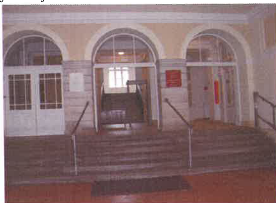
Obr. 3 – vchod okresného súdu, vľavo stanovisko justičnej stráže
