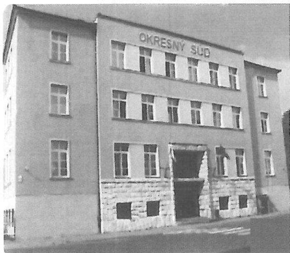
Obr. 1 – budova Okresného súdu Levice
