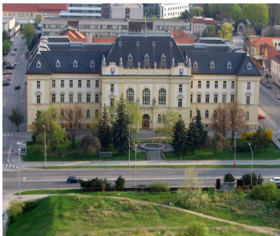
Obr. 1 – budova Okresného súdu Nitra
