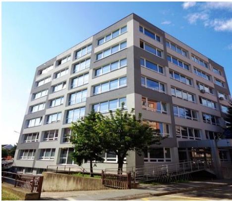
Obr. 1 – budova Okresného súdu Nové Zámky
